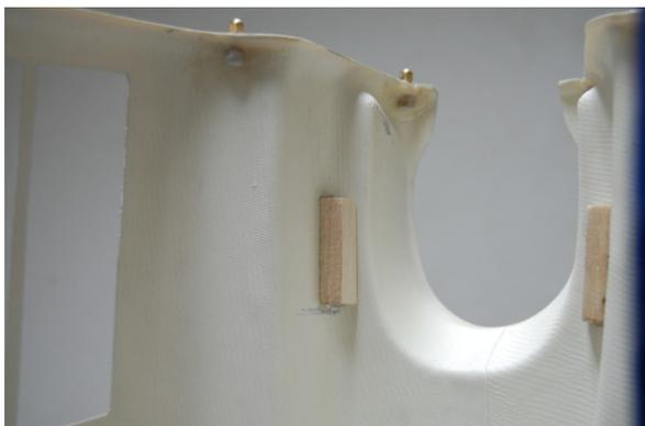
Die Paszdübel können nun eingeklebt werden. Richten Sie die Dübel passgenau aus.
